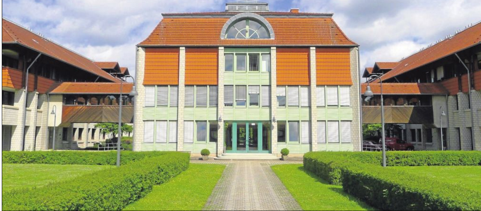
Das Kammergebäude aus dem Jahr 1984 soll nach dem Willen des neuen Eigentümers abgerissen werden.
