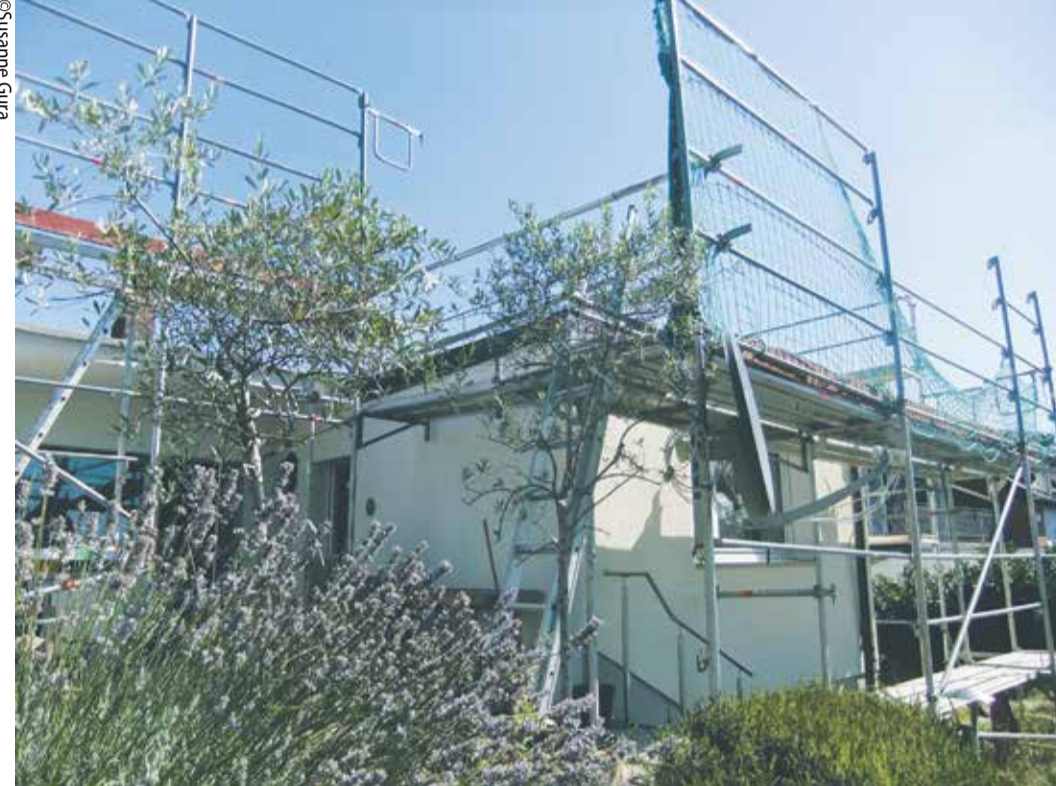
Das Dach ist abgebaut, bald kommt der Holzaufbau für zwei weitere Wohnungen.
