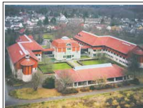
Die ehemalige Landwirtschaftskammer ist ein Musterbeispiel für ein weiter nutzbares Bürogebäude. Foto: LRBS
